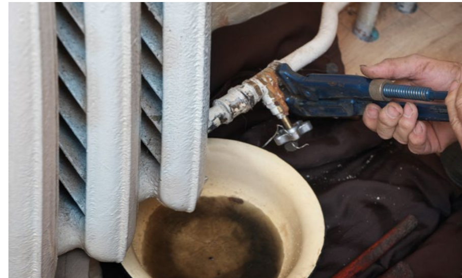
CIRCUIT DE CHAUFFAGE EMBOUÉ
