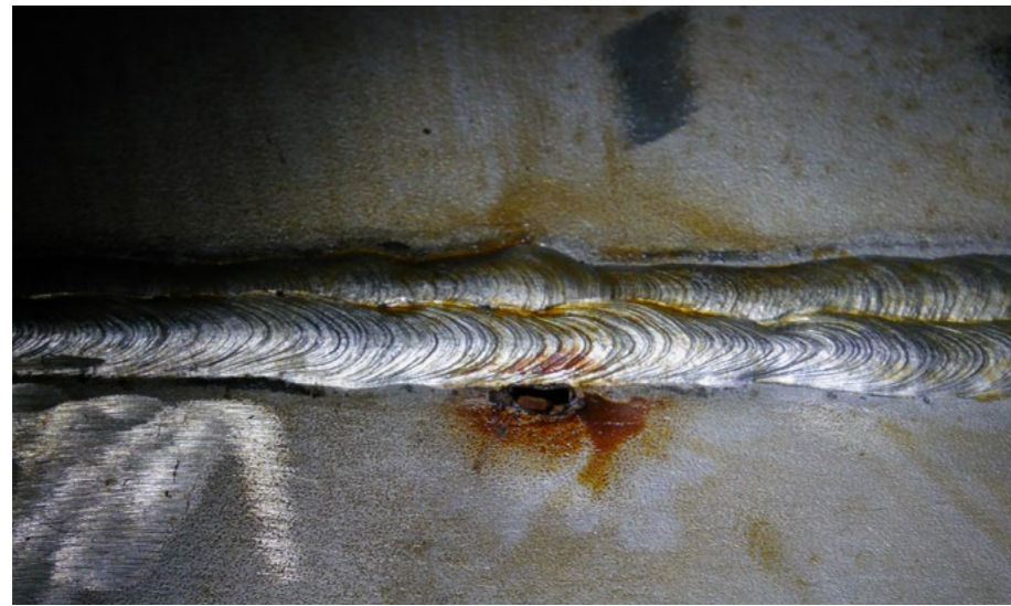
PIQÛRE DE CORROSION SUR INOX
